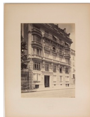
2 : Immeuble à loyer, rue du Luxembourg
