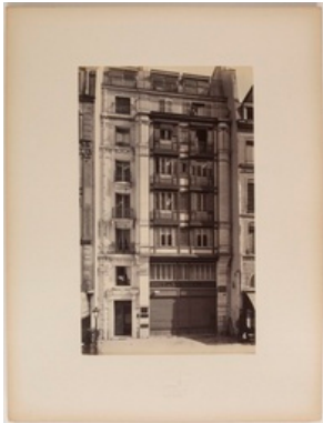
6 : Maison à loyer, rue du Louvre
