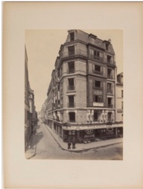
7 : Maison à loyer, rue de Sèvres
