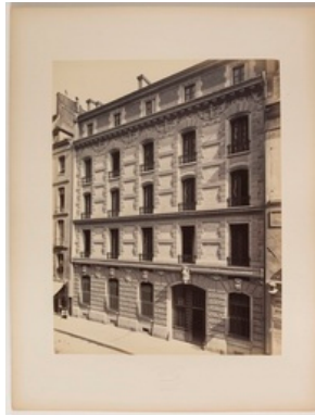
22 : Caserne de sapeurs-pompiers, rue
