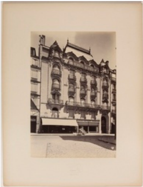
18 : Masion à loyer, rue de Clichy
