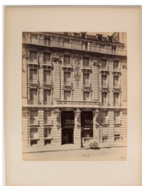
24 : Maison à loyer, rue de la Pompe
