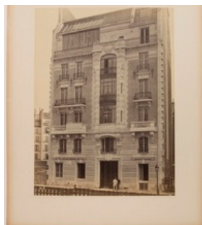
43 : maison à loyer, rue Ampère
